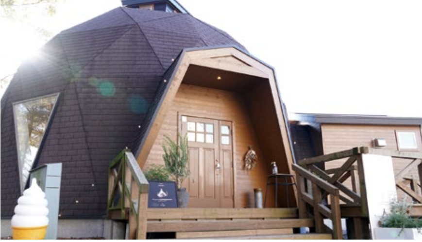
▲店舗は森林に囲まれたグリムの館敷地内。ドーム型の建物が目印です。
